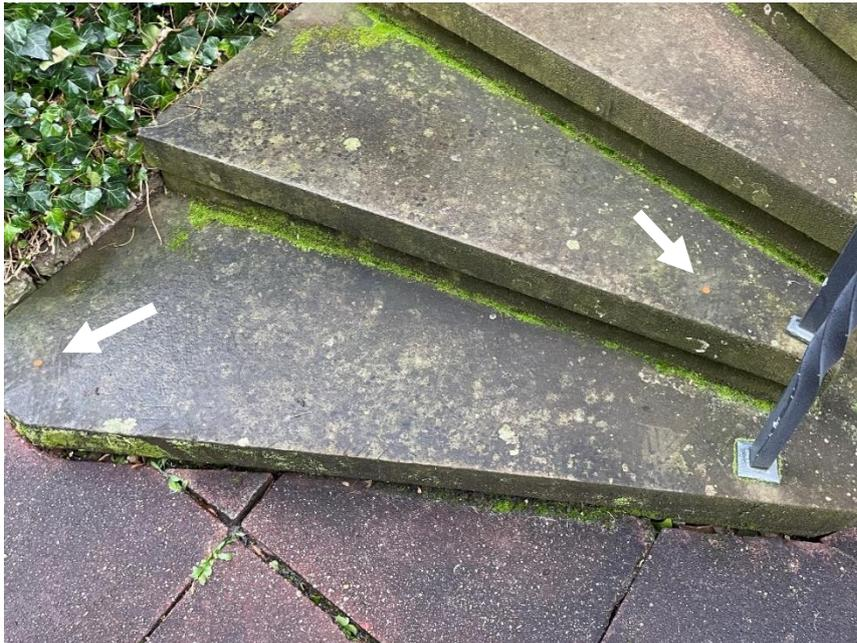
Abbildung 26: Photogrammetrische Aufnahme mit Klebepunkten (bei weißen Pfeilen)
