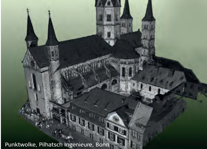
Punktwolke, Pilhatsch Ingenieure, Bonn
